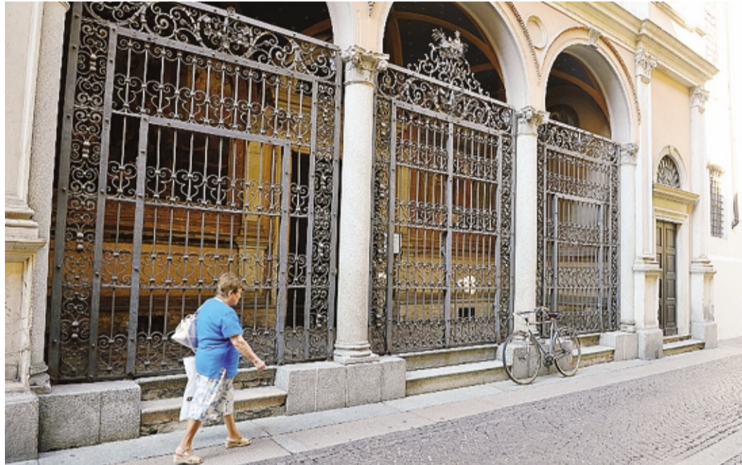
Per due settimane il gioiello artistico del Rinascimento sarà oggetto di interventi di manutenzione dei sottotetti
