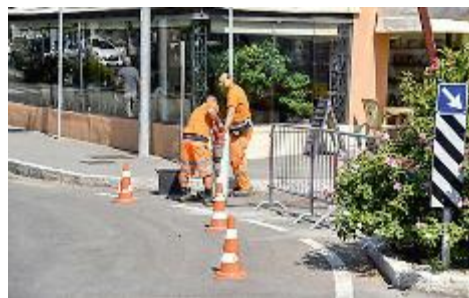
INTERVENTO Lavori stradali in corso per il doppio senso in via Borgo Adda
