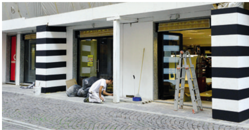
In alto le vetrine chiuse di Sephora. Sotto, i lavori prima dell'apertura in corso Roma
